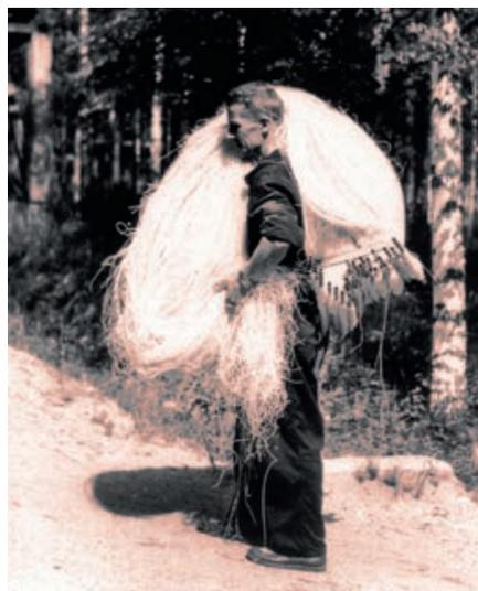
Um perforiertes Pulver zu erhalten, wird der Teig durch eine Nudelpresse gedrückt. Die langen Stränge wurden früher so transportiert.
