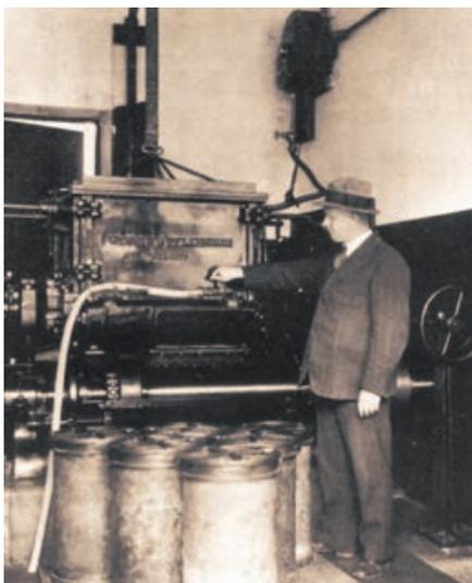
Aus einer anderen Zeit: Im Anzug bei einer Knet- und Mischmaschine. Werner & Pfleiderer fertigt Maschinen für Bäckereien. Die Nitrozellulose wird gemischt mit Lösungsmittel wie Ethanol und später Ether. Das Endprodukt ist ein schöner Teig für die Presse.
